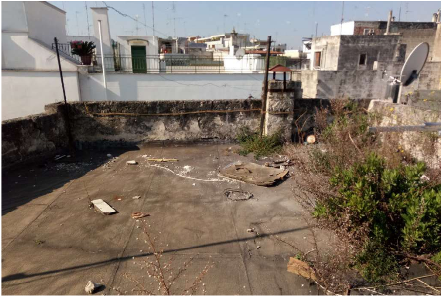
Foto della copertura
